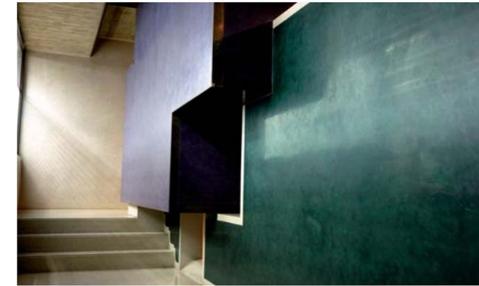
4. La scala, ad uso del personale, è di collegamento tra i piani rialzato, seminterrato e interrato. La sua notevole forza plastica elimina in chi la percorre l'effetto "sottoscala", creando mediante ripetuti tagli del setto murario portante, una complessa continuità spaziale.
